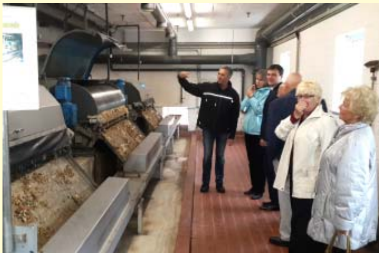
Die Besuchergruppe während der Besichtigung der Kläranlage.
