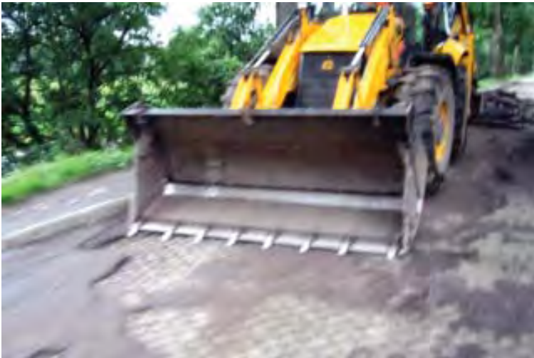
Straßenbauarbeiten in Wehlau
