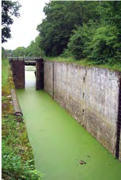
Die gut erhaltene Schleuse des Masurischen Kanals bei Allenburg
