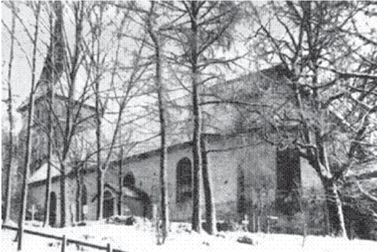
Die Kirche von Goldbach im Winter. Auf dem angrenzenden Friedhof sind meine Großeltern beigesetzt. Hier wurde auch meine Mutter im Januar 1946 begraben. Zu der Zeit war die Kirche, wie hier abgebildet, noch intakt.
