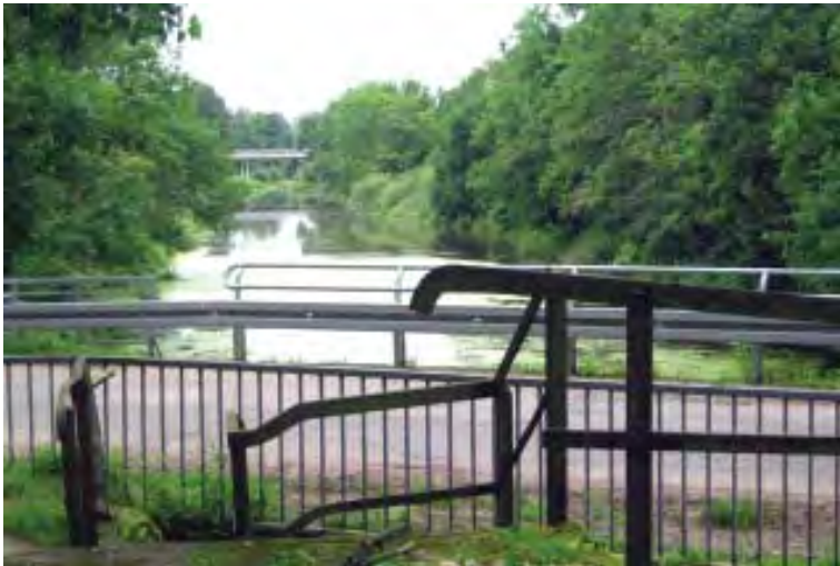
Die Brücke über den Masurischen Kanal 2011
