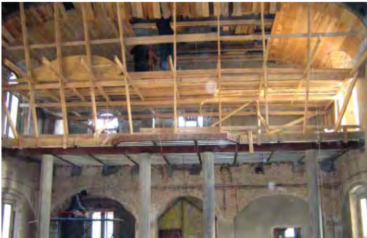
Bei den Innenarbeiten in der katholische Kirche in Wehlau
