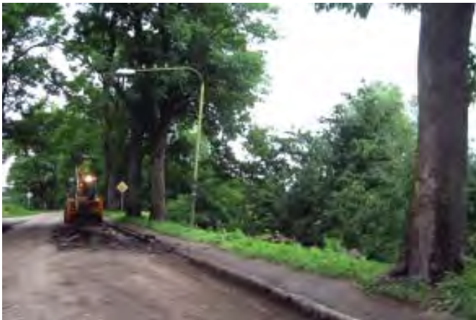
Straßenbauarbeiten in Wehlau
