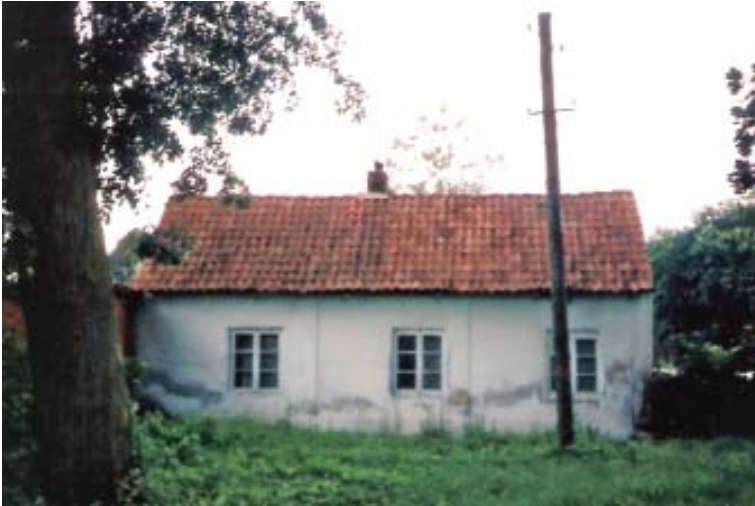
Die zum Wohnhaus umgebaute ehemalige Waschküche
