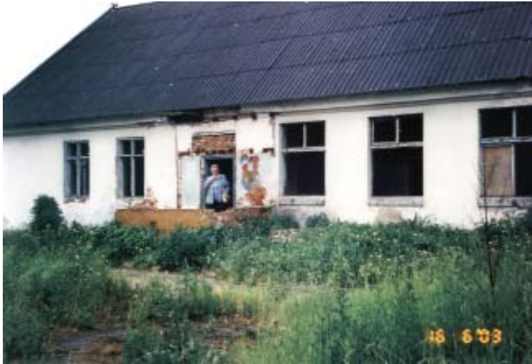
Das Schulgebäude in Poppendorf
