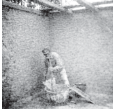
Heini Dummann verputzt die Wand des geplanten Schlafzimmers
