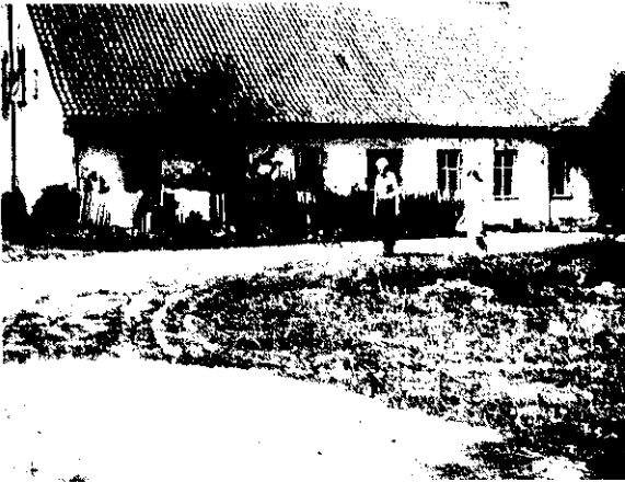
Das Haus von Gedat steht noch (Foto: F. Neumann)
