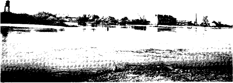
Links die Deime, hinter dem Ufer und Gebüsch fließt der Pregel. Im Hintergrund das frühere Holzlager und Fährkrug.
