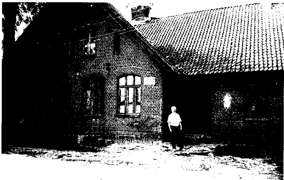
Die frühere Schule in Bürgersdorf 1993. (Foto: G. Kalweit)
