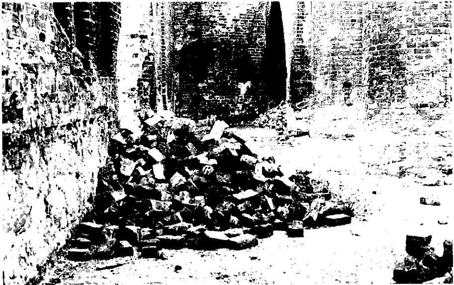
Südliches Seitenschiff. Blick auf Westwand. Im Hintergrund: Aufgang zur früheren Orgelempore. (Foto: Benz)
