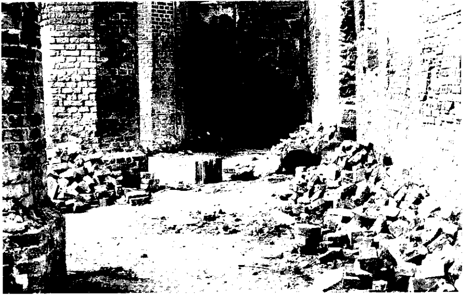
St. Jacobi Wehlau. 28. Sept. 1994. Das nördliche Seitenschiff der Kirche. Die Ziegel sind von Hand aus dem Schutt herausortiert. (Foto: Benz)
