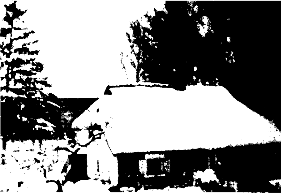
Haus Pauloweit vor 1945, dahinter Scheune der Domäne (Foto: Pauloweit)
