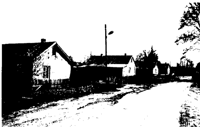
Auf dem früheren Sportplatz wurden kleine russische Häuser errichtet. Petersdorf 1991 (Foto: Pauloweit)
