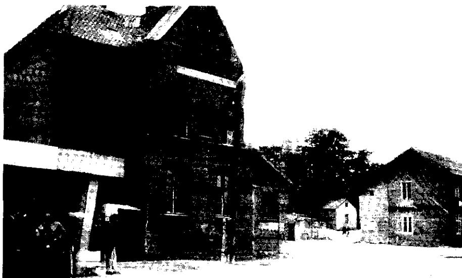
Die noch in Betrieb befindliche Post in Goldbach, dahinter die Reste der Molkerei. (Foto: E. Müller)
