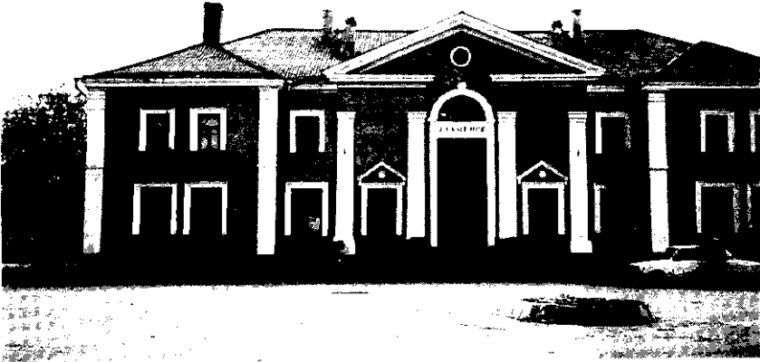
Wehlau, Bahnhofsgebäude 1991. Oben: Vorderseite.
