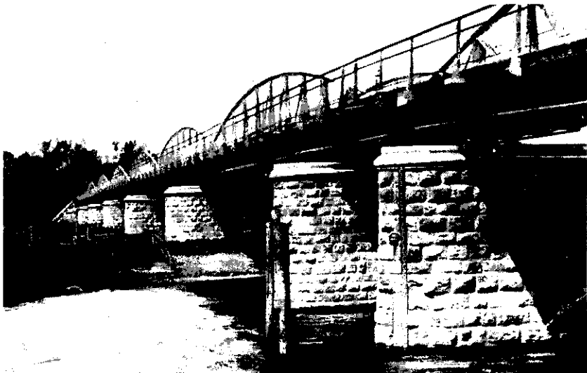
Lange Brücke in Wehlau. Diese Aufnahme zeigt die Brücke vor der Sprengung im August 1914. Das Bild stellte uns Frau Scheffler (Buchdruckerei) zur Verfügung.
