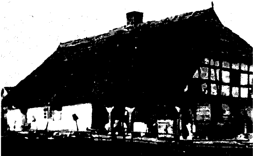
Altes Bauernhaus in Starkenberg mit Krüppelwalm, Fachwerkgiebel, Giebelständer und Vorlaube an der Längsseite; Wände sind waagerechte Balkenholzlagen.
