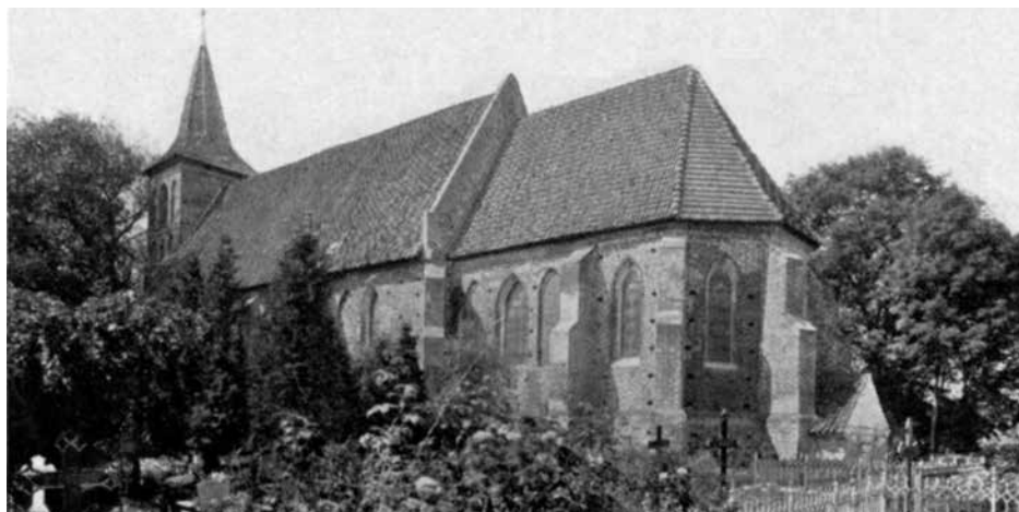
Die ev. Kirche in Kremitten von Süden etwa 1925, in: Deutschlands Landbau Ostpreußen, Berlin 1928, S. 21 r.o.
